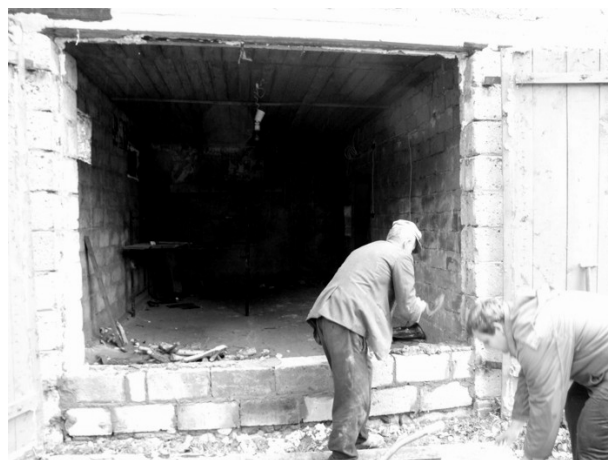
Rozpoczął się remont remizy OSP w Woli Kuźniewskiej. Właśnie trwają prace przy obsadzaniu nowego dużego okna
