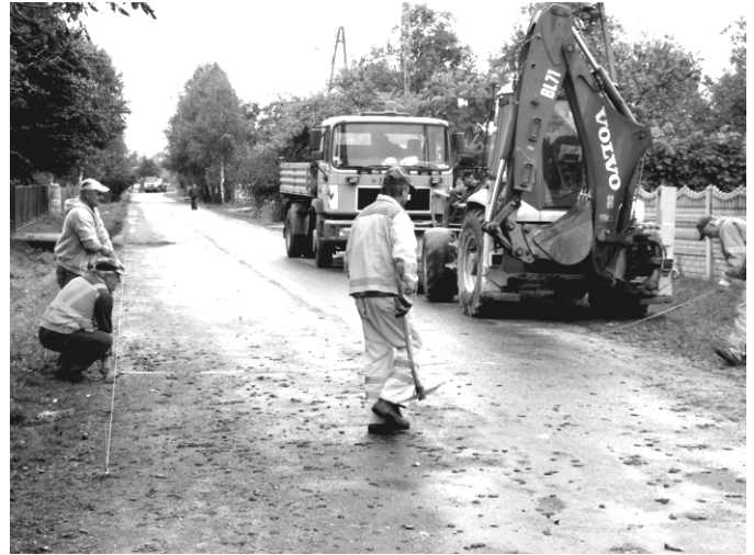
Rozpoczęcie remontu na drodze w Trzebcach
