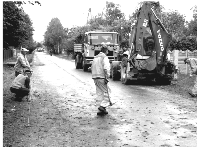
Rozpoczęcie remontu na drodze w Trzebcach
