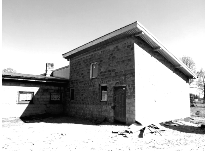
Rozbudowa remizy OSP w miejscowości Trzebce
