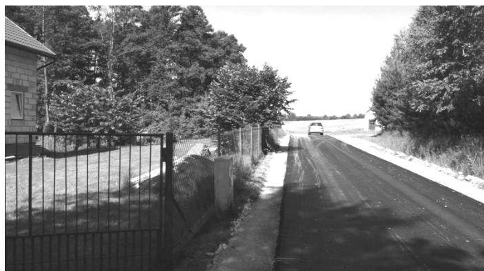
Położenie masy bitumicznej na drodze w miejscowości Rudka
