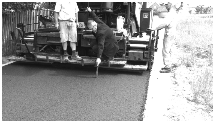
Kładzenie i masy i sprawdzanie jej grubości na ul. Rolnej w Krzętowie
