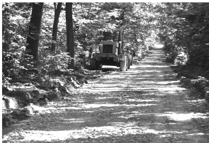
Wykonanie podbudowy na drodze pomiędzy Rogami a Krzętowie
