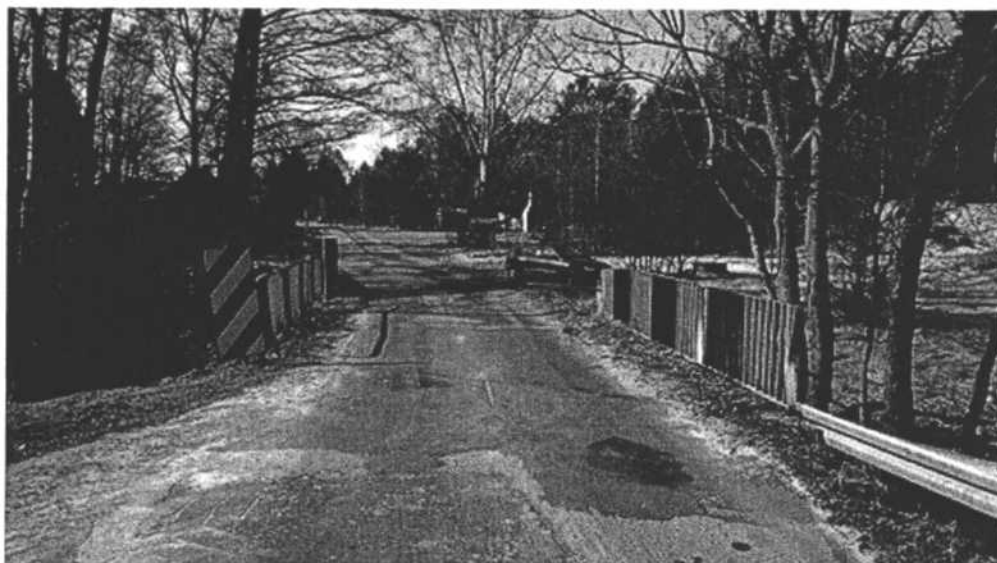
Fot. 2.1. Widok mostu od strony gminy Wielgomłyny
