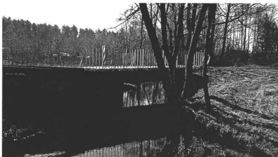
Fot. 2.3. Widok mostu od strony wody górnej
