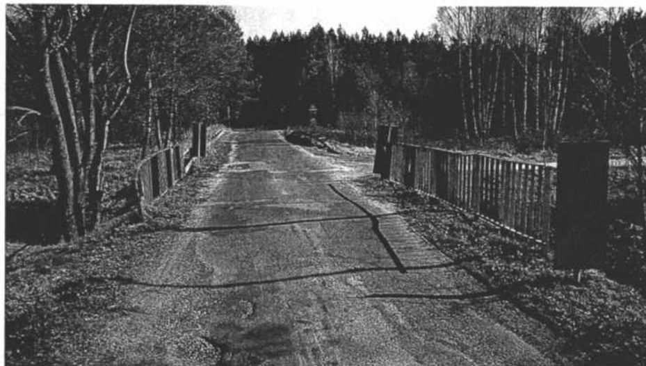
Fot. 2.2. Widok mostu od strony Silnicy
