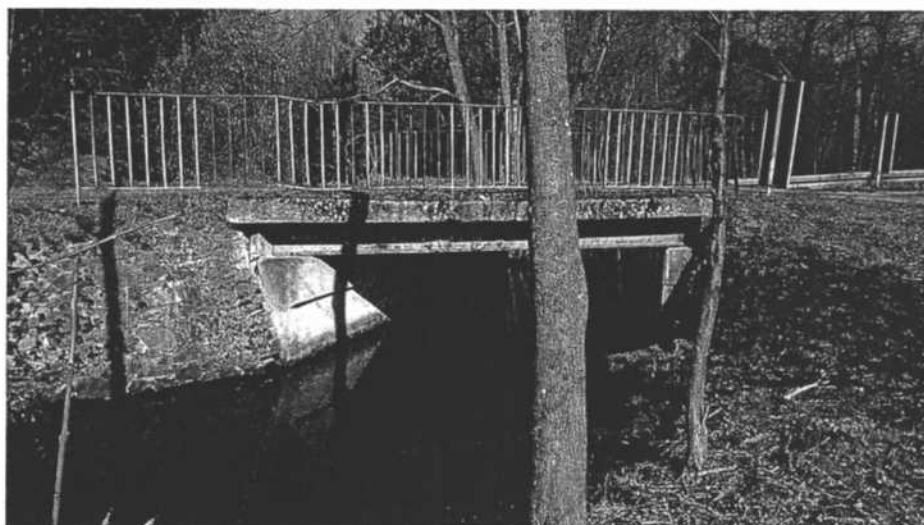
Fot. 2.4. Widok mostu od strony wody dolnej
